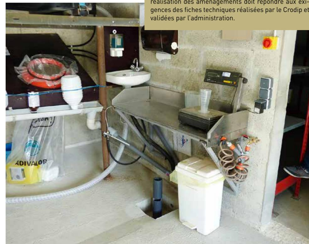
> Paillasse de préparation sur poste de remplissage sécurisé.
